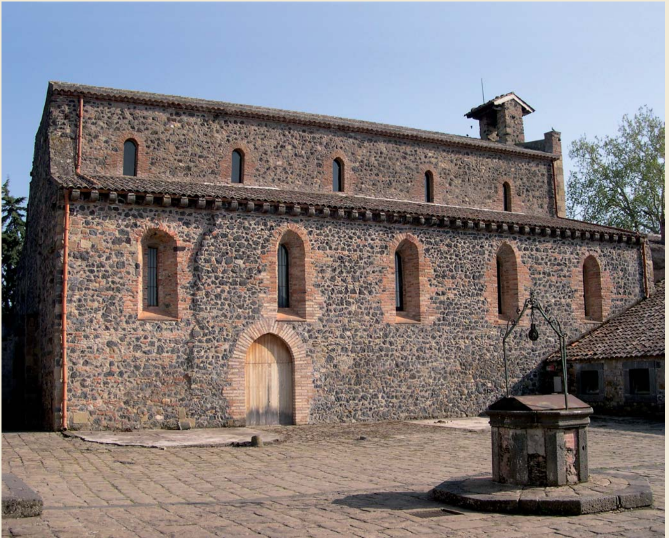
Fig. 7 - Il lato esterno della navata di sinistra dopo il restauro (foto Associazione Bronte Insieme Onlus).
