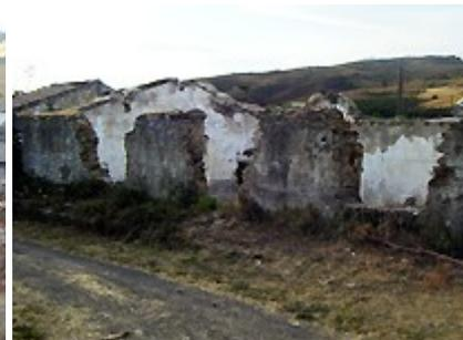
Fig. 29 - In questa foto si riconoscono i varchi delle finestre di consegna dell'uva alle piste (vedi lett. "P" in Fig. 53) e tracce del ballatoio ("BE")
