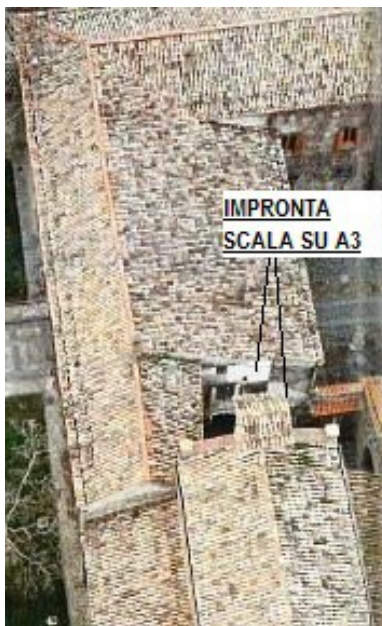
Fig. 23 - Impronta della scala esistente sino al 1981 su parete del Corpo A3 e poi demolita (tratta da N. Galati - "Il Castello dei Nelson", G. Maimone Editore, Catania, 2006).
