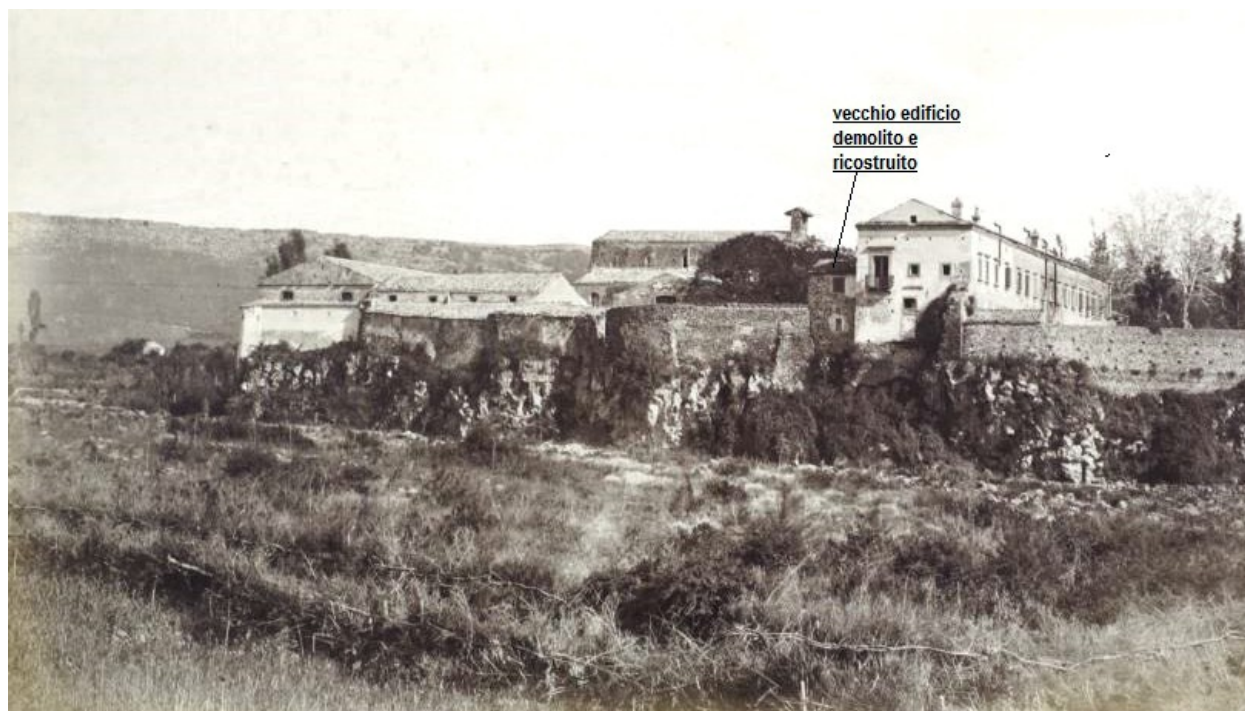
Fig. 12 – Castello Nelson, vista dal fiume (foto, probabilmente del 1874, concessa da Lord Bridport).
